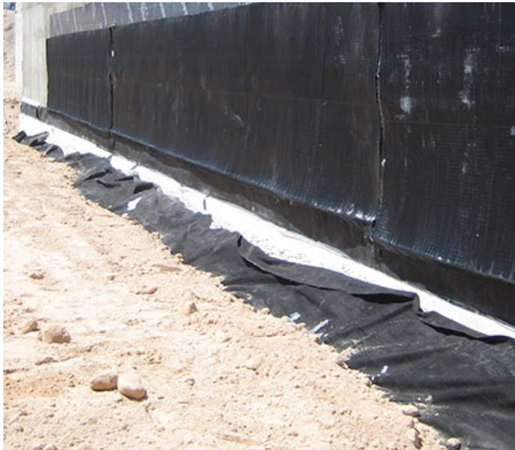
A construção do aeroporto na Irlanda exigia impermeabilização da área dos porões, abaixo do nível do solo, especificamente das paredes e das colunas de concreto reforçado. Situado em um terreno inclinado, os engenheiros projetaram um dreno abaixo do nível do solo sob a laje, como não se tratava de um porão monolítico. Assim, também era necessária uma membrana adequada para aplicação em áreas úmidas.
